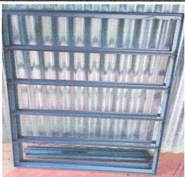
Foto 5: Elavoracion de las ventanas.
