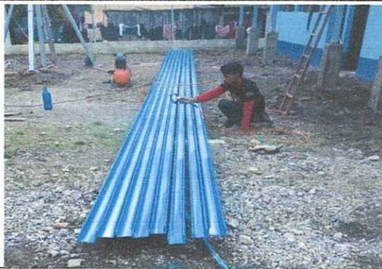
Foto 2: pintado de las costaneras para el entechado del patio.
