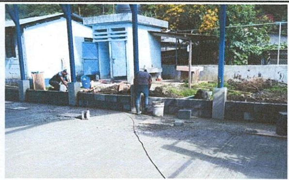
Foto 2: Levantamiento de block al contorno de la losa de patio.
