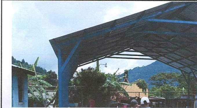
Foto1: mejoramiento de caída de aguas pluviales (COLOCACION DE TUBERIA).
