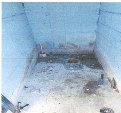
Foto 3: Se procedió a quitar los baños en mal estado .
