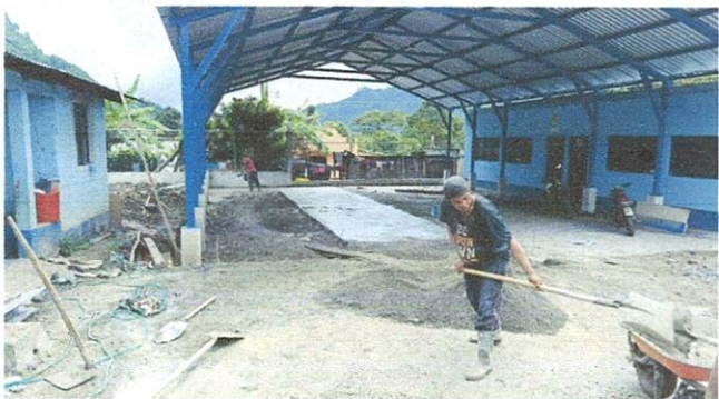
Foto1: Fundición de losa de patio.
